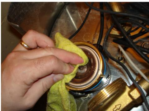
Le boîtier de la pompe doit également être nettoyé.
