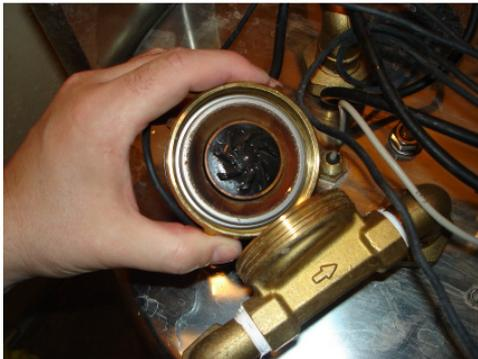
A l'intérieur de la pompe, seule la tête du rotor est apparente.
